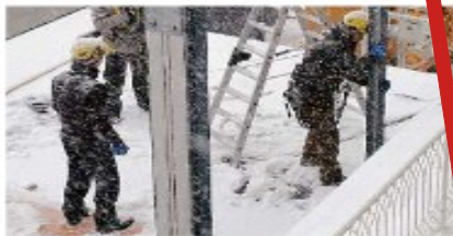
Abbau nach dem WEF. Bild: Marcel Giger snow-world.ch
